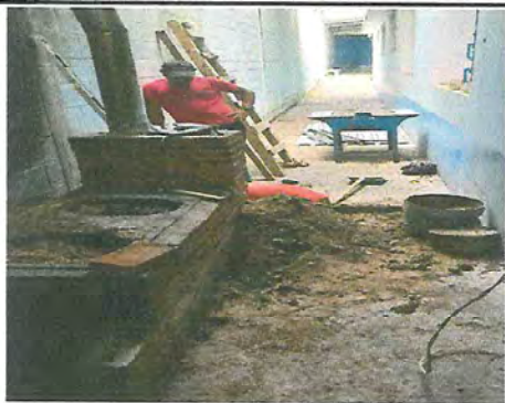
Foto 1: Se inicia el proyecto con reparación de la cocina colocando piso tipo azulejo, cerámico y se sustituye la estufa de leña.
