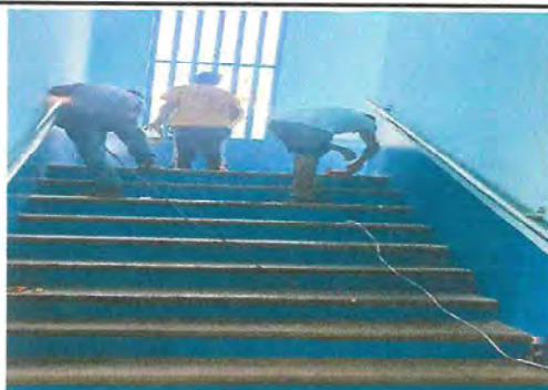
Foto 5: Se inicia a reforzar con acero inoxidable el pasamanos en gradas.
