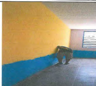
Foto 2: Se inicia a pintar las paredes de las aulas y el zócalo
