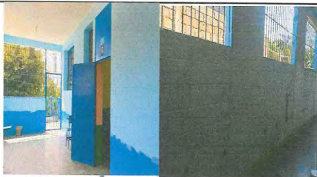
Foto 3: Se pintan las paredes de los corredores, muros y el zócalo y donde había humedad se colocó impermeabilizante.
