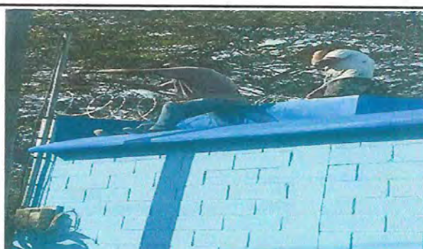
Foto 6: Se inicia a instalar rayzor en muro perimetral como seguridad de la escuela
